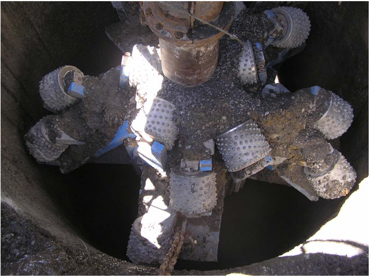
Obr.2 Těleso po dokončení rozšíření
