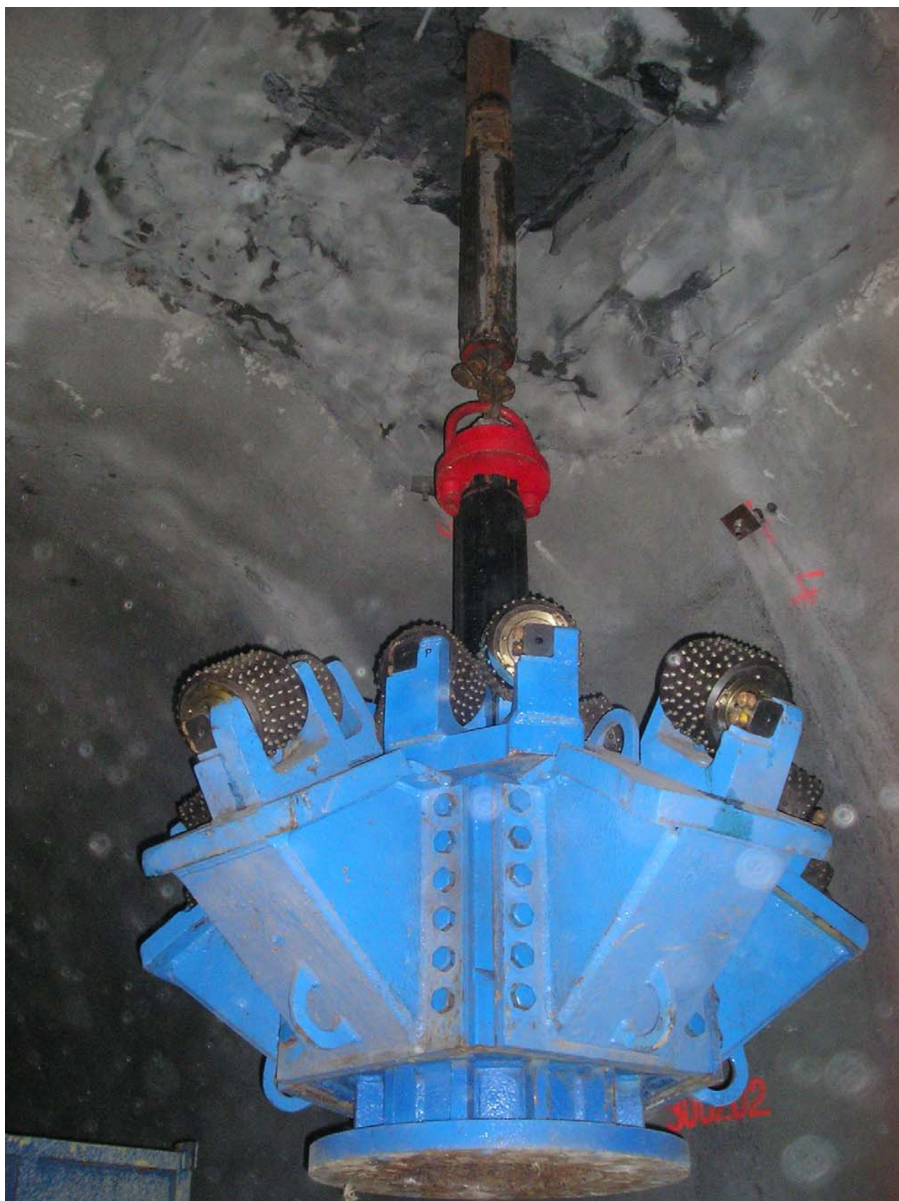
Obr.1 Usazené rozšiřovací těleso v tunelové spojce
