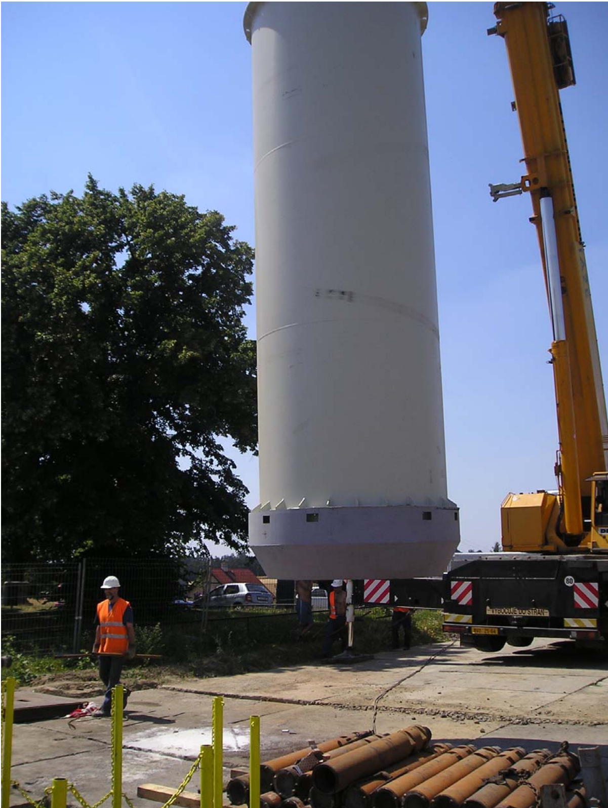
Obr.4 Roura číslo jedna s naváděcím prstencem připravena k usazování
