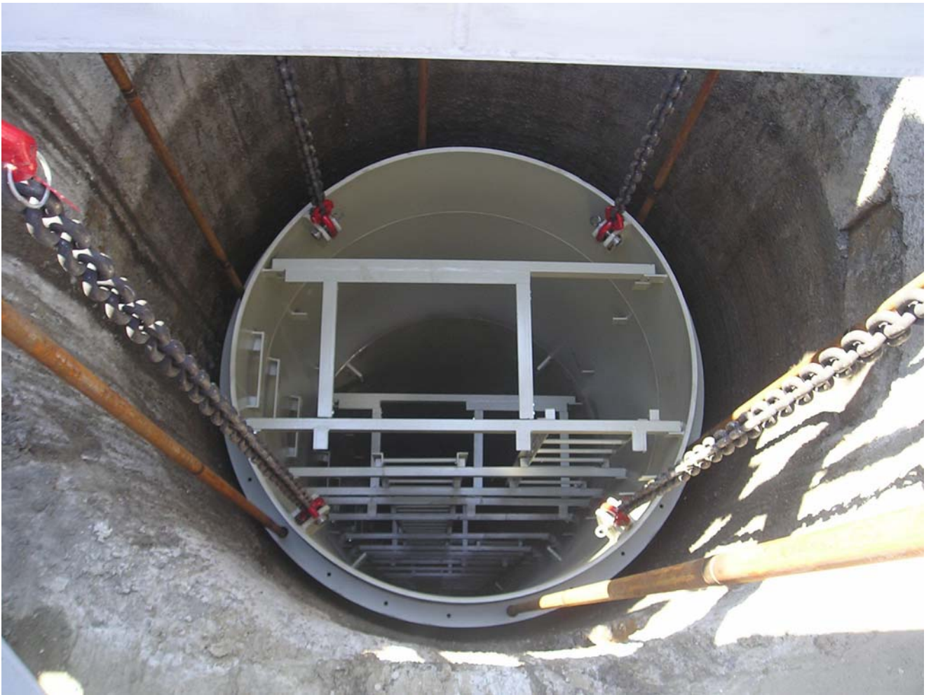
Obr.5 Výškové usazení na řetězových závěsech
