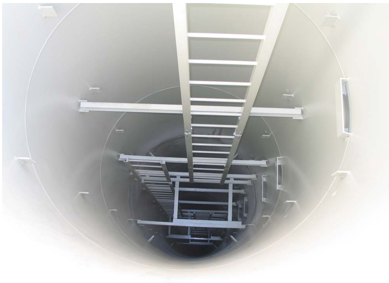
Obr.6 Pohled do vystrojované šachtice
