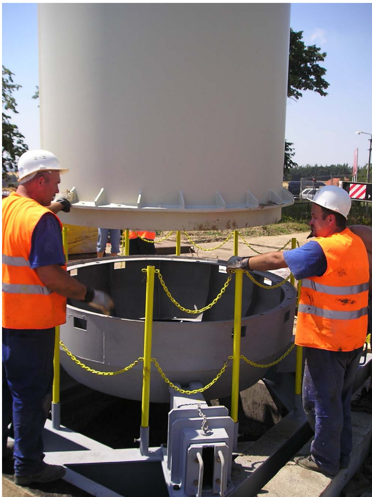
Obr.3 Naváděcí prstenec na popouštěcí stoličce
