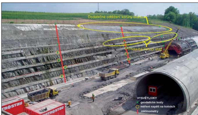
Obr. 6 Schéma rozmístění prvků monitoringu na části jižní stěny stavební jámy hloubeného úseku Brno společně s naznačenou lokalizací dodatečných opatření pro sanaci svahu (foto Stach)
