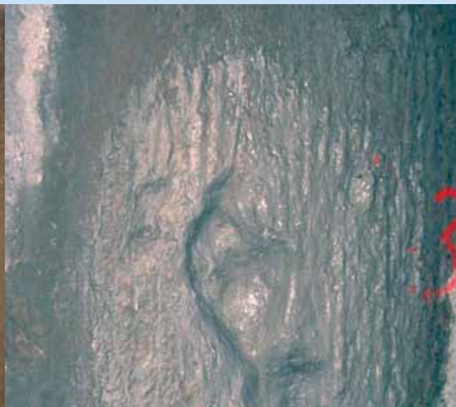
Obr. 6: Sanace místa s pruníkem vody
