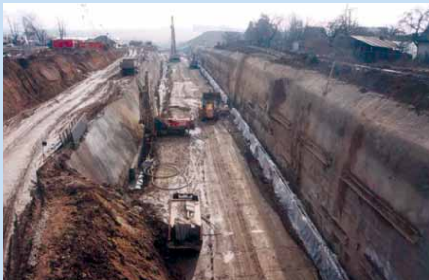
Obr. 11: Celkový pohled na stavební jámu pro provádění podzemních stěn
