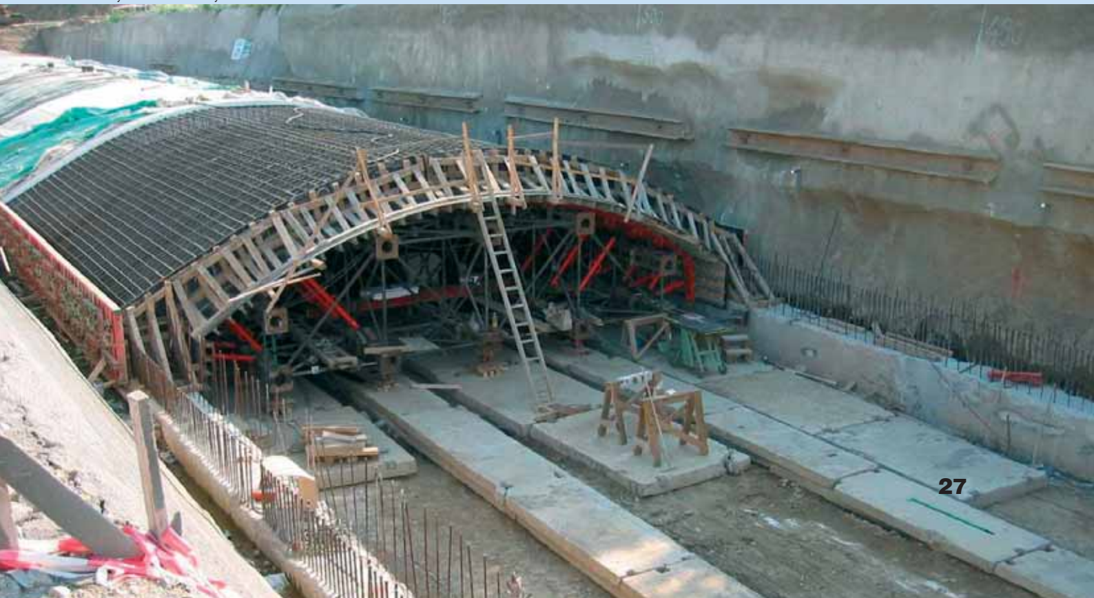
Obr. 9: Výstavba tunelové klenby
