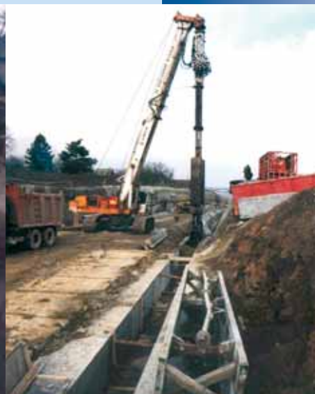
Obr. 12: Těžba rýhy podzemních stěn
