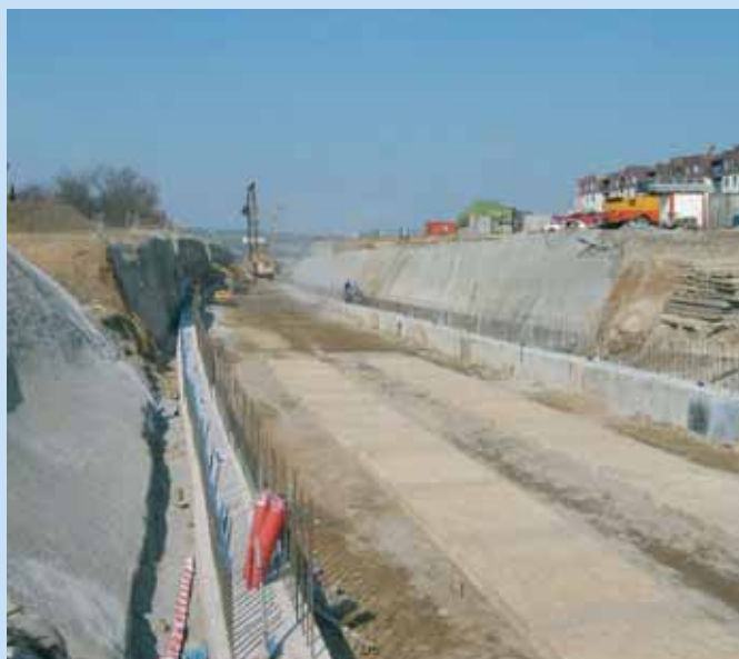
Obr. 7: Podzemní stěny před betonáží klenby
