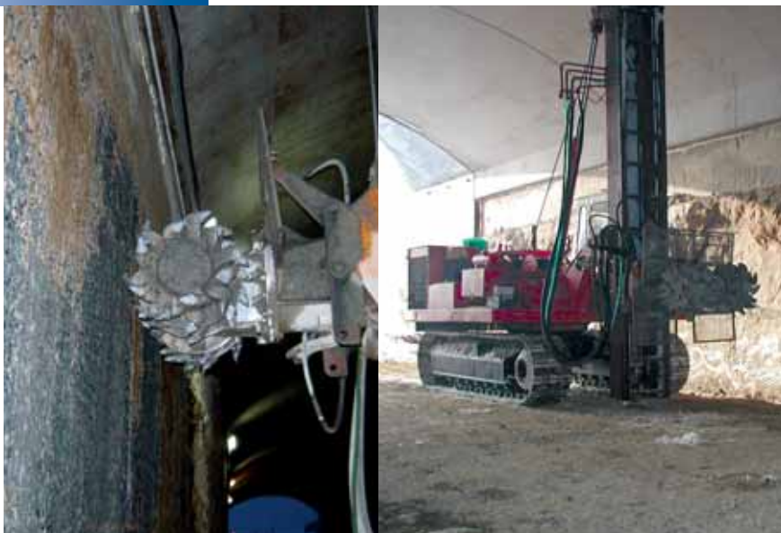
Obr. 14, 15: Fréza pro začištění líce podzemních stěn
