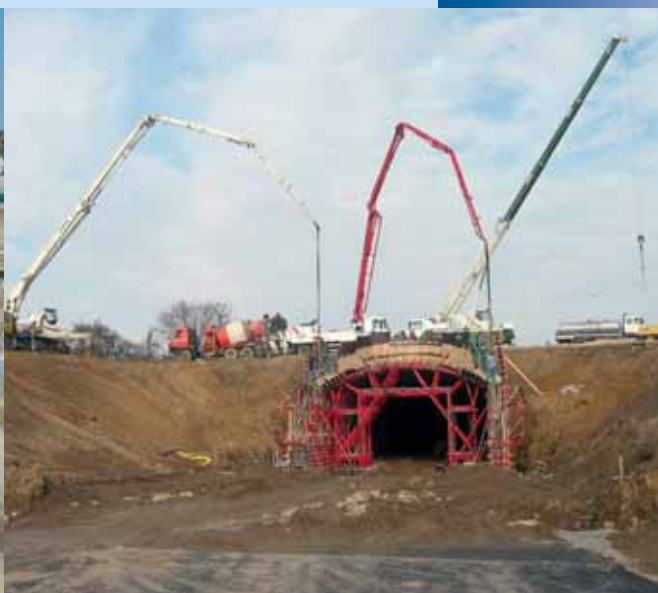
Obr. 8: Betonáž jižního portálu
