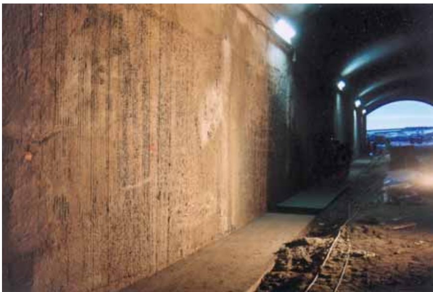
Obr. 16: Konečná úprava líce podzemních stěn
