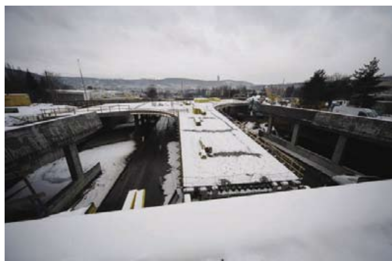
▼ Předportálí Žabovřesky, výstavba mostů, opěrných zdí, galerií, lávek pro pěší a velkého množství přeložek inženýrských sítí
