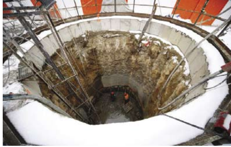
▲ Jedna ze studen pro přečerpávání podzemních vod
