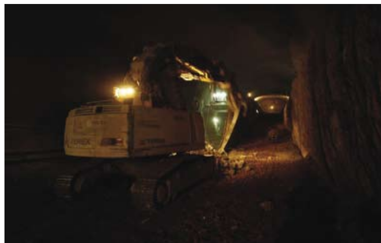
▲ Práce na vybourání vnitřních výztuh dílčích výrubů
