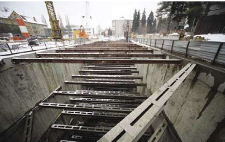
▲ Výstavba sedmi podzemních podlaží technologického centra
