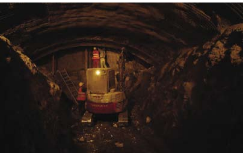
▲ Práce na instalaci vnitřních výztuh dílčích výrubů
