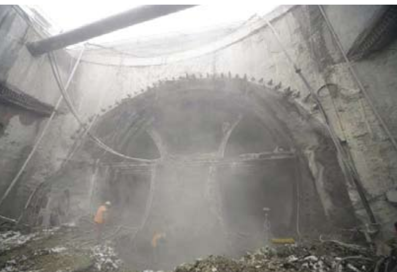
▼ Práce na portálu v Žabovřeskách, postup pomocí šesti dílčích výrubů
