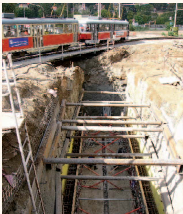
Pažení s tramvajovým provizoriem
