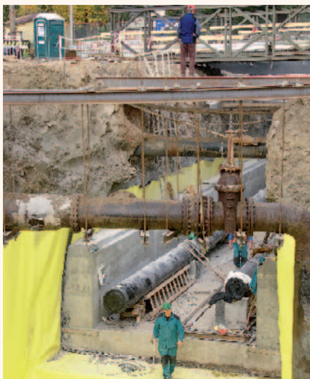
Na snímku těleso podchodu před zastropením
