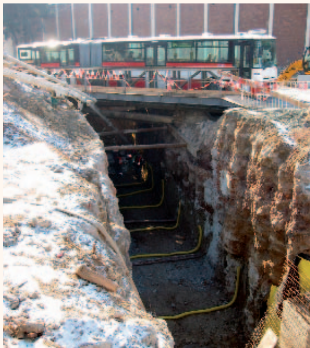
Pažení s mostním provizoriem
