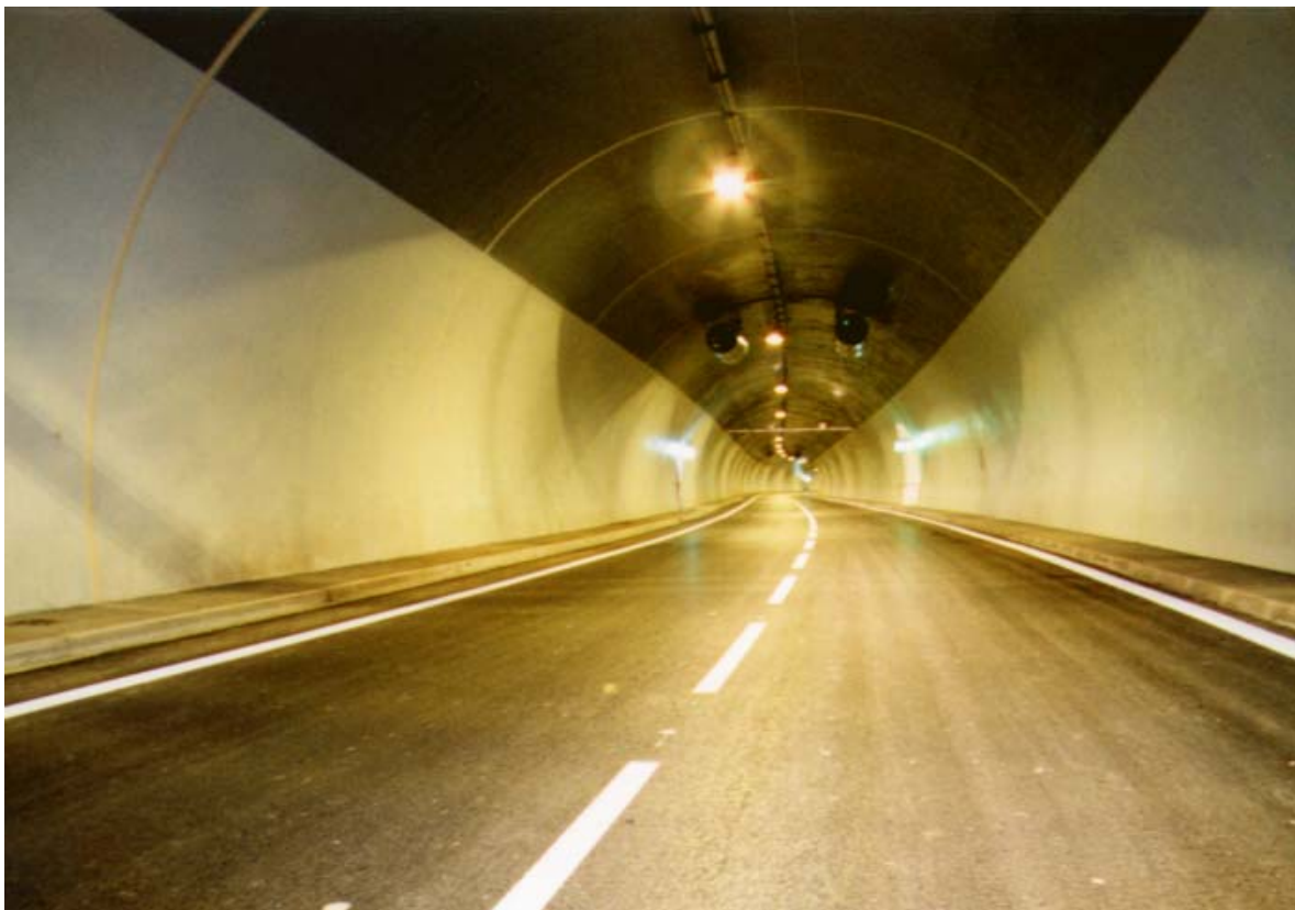
Obr. 7 Hotový tunel před otevřením
