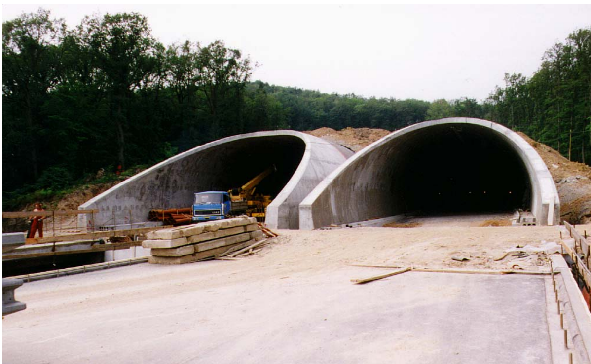
Obr.4 Pisárecký portál před zasypáním
