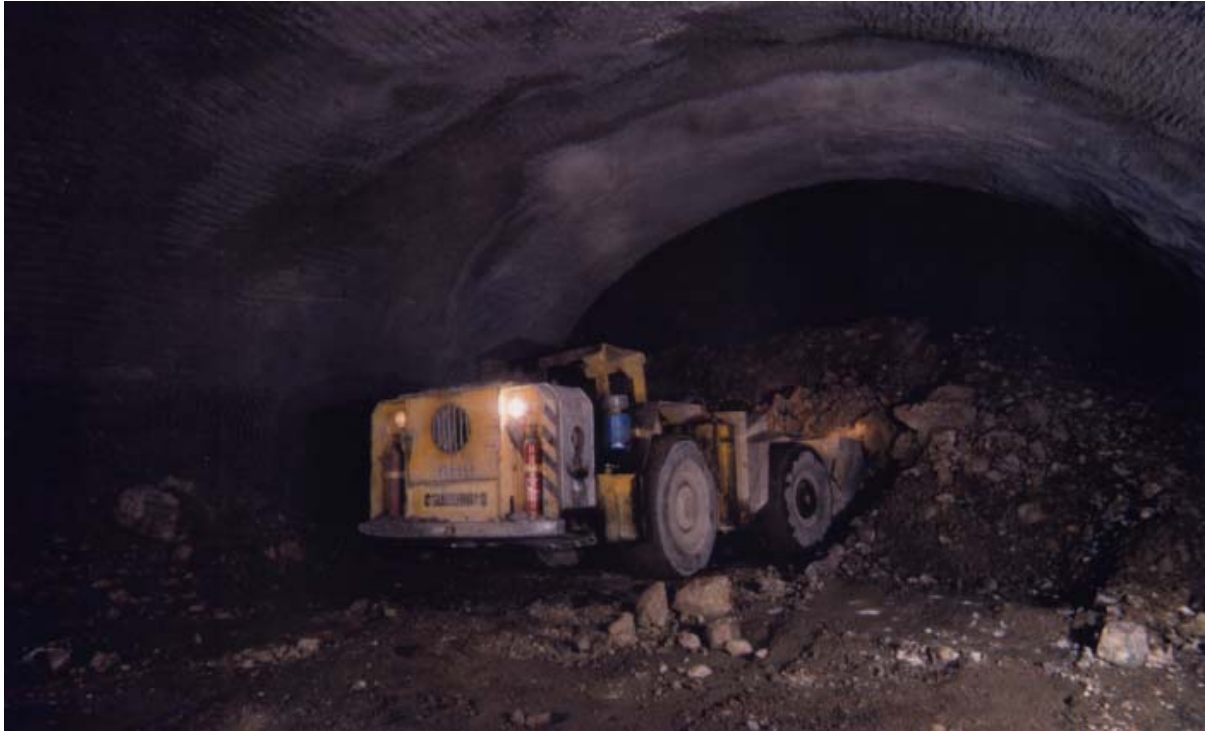
Obr. 6 Ražba kaloty tunel
