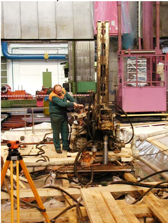
Obr. 6 : Vrtací práce v železovém betonu základu – provádí ZAKLÁDÁNÍ STAVEB, a.s.
