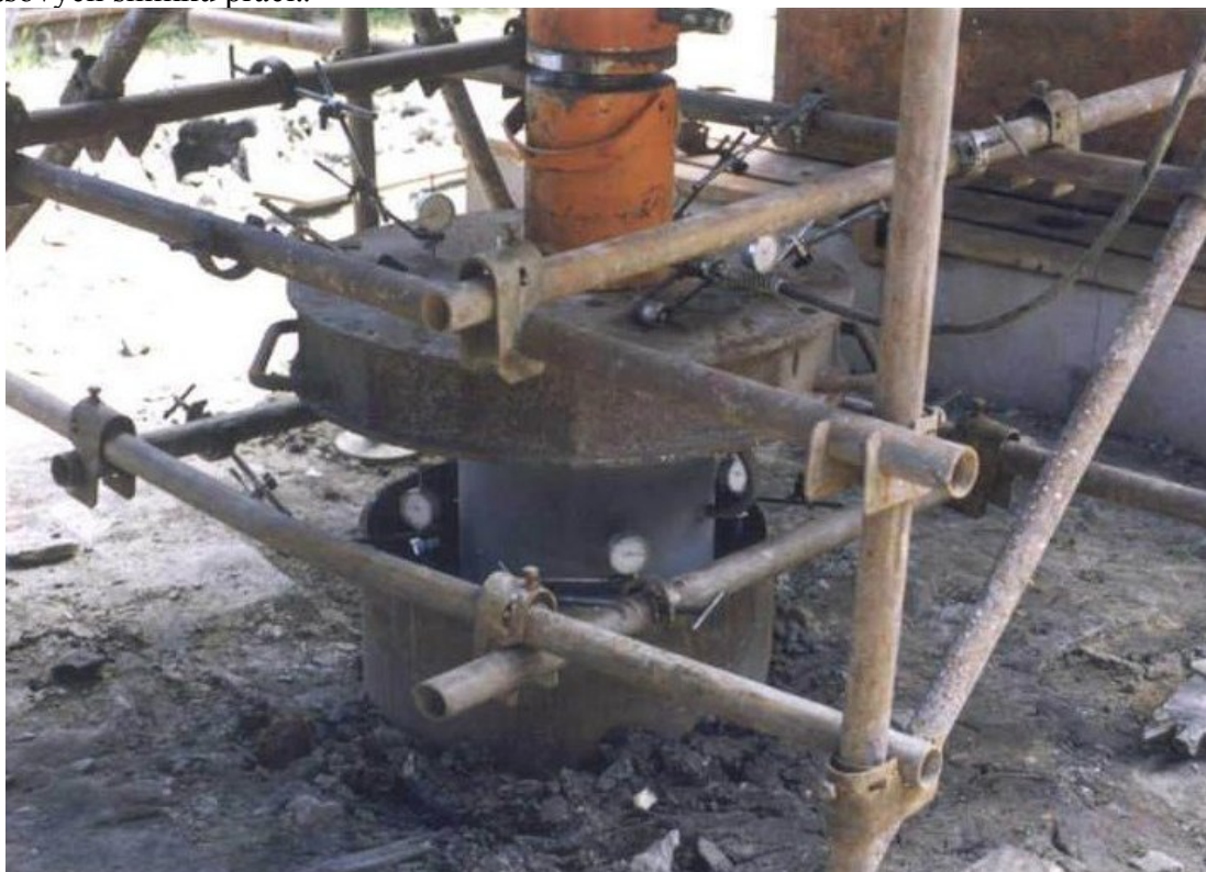
Obr. 3 : Zatěžovací zkouška zkušebního pilíře TI
