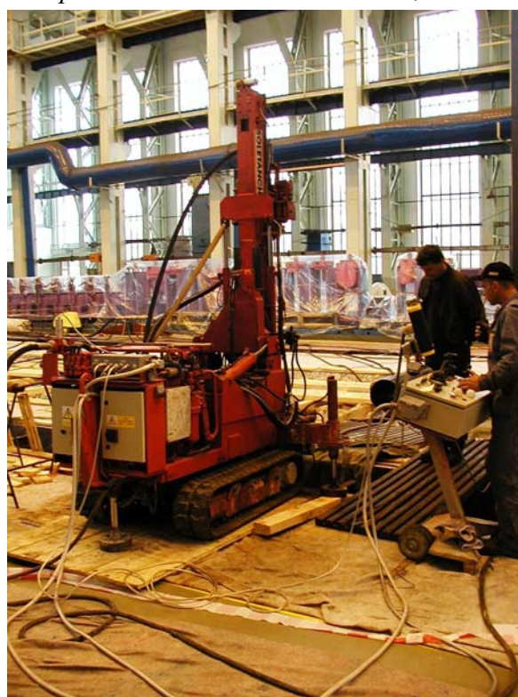
Obr. 7 : Realizace pilíře TI – provádí SOLETANCHE ČR
