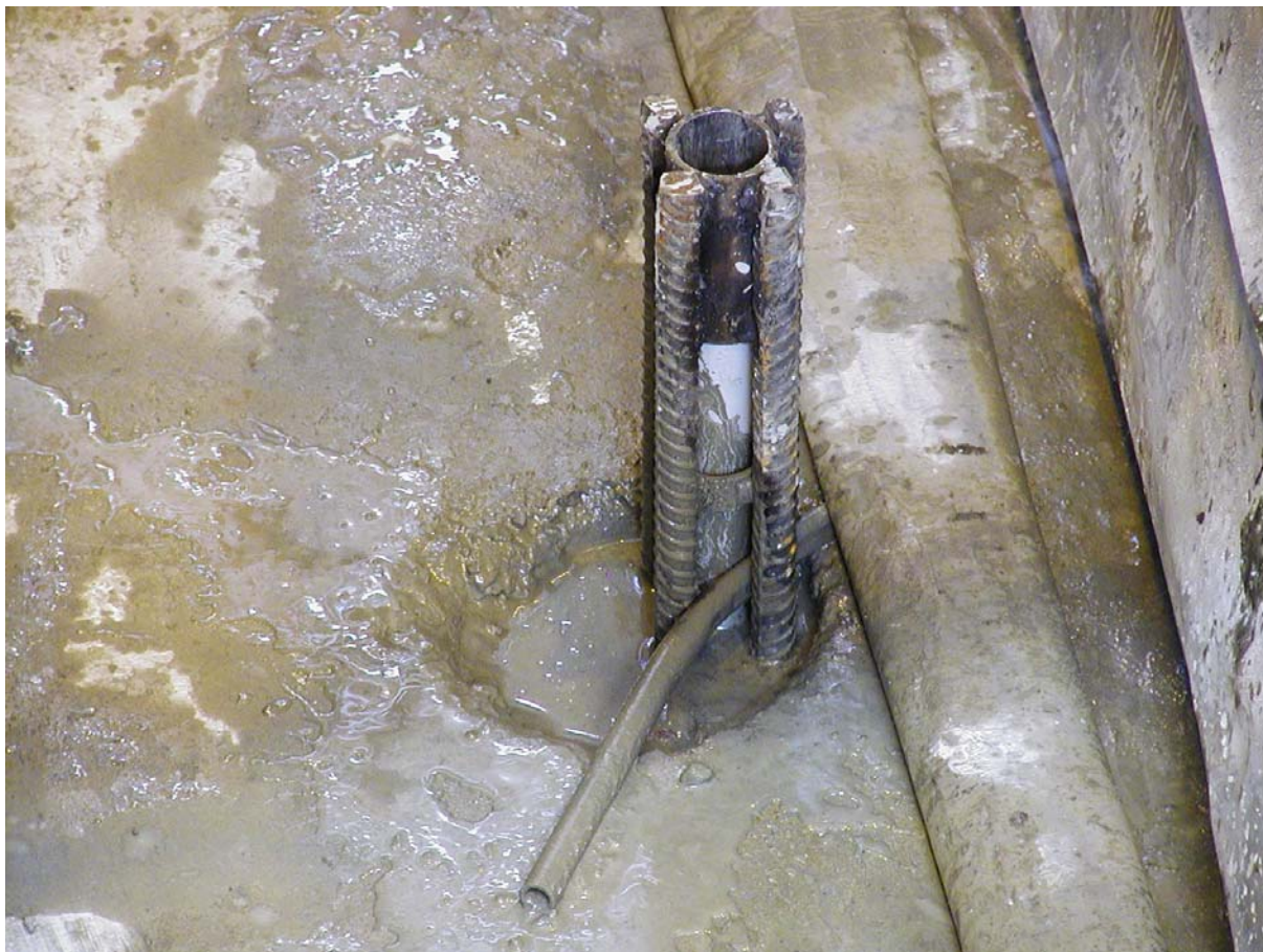
Obr. 8 : Zesílení pilíře TI a vrtu v betonu základu vloženým armokošem
