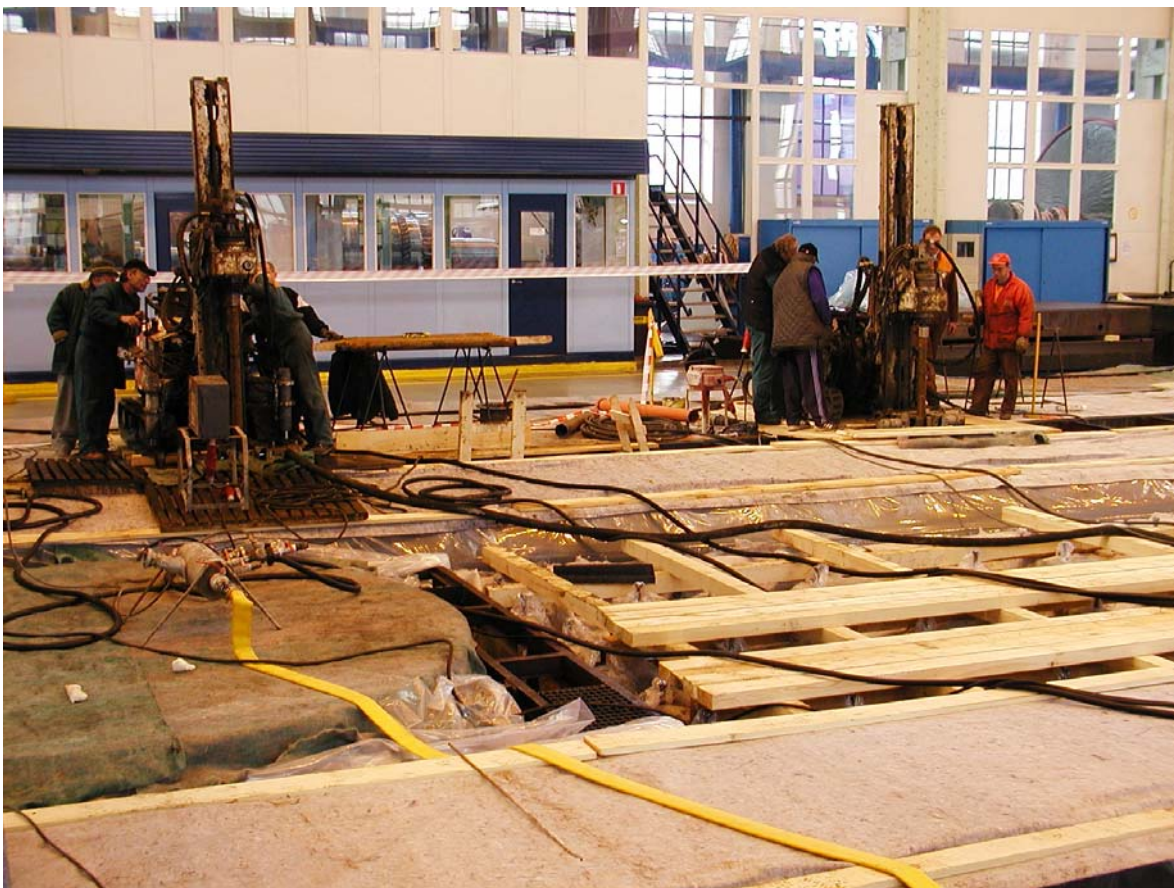
Obr. 5 : Vrtací práce v železovém betonu základu – provádí ZAKLÁDÁNÍ STAVEB, a.s.
