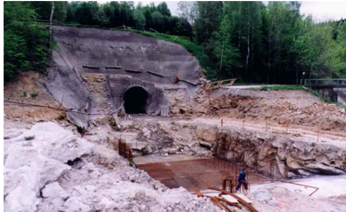
Výtok z tlakové štoly s vývařístem
