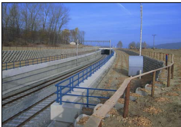
Předpolí a západní portál tunelu
