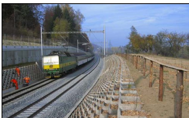
Zajištění svahu kolem km 8,100
