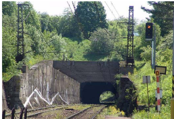
Výjezdový portál tunelu – zárubní zdi z rozpěrami
