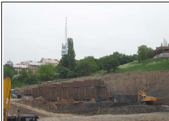
Pohled na záporovou stěnu
