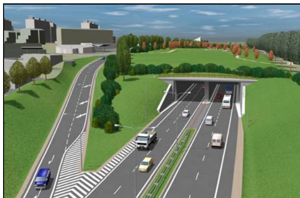
Jižní portál tunelu R43 – příjezd od dálnice D1
