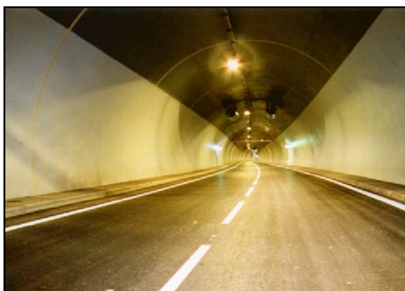
Dokončené vnitřní ostění
