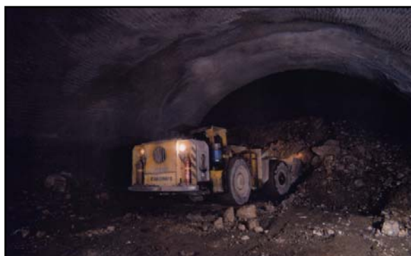
Výrub kaloty, primární ostění ze stříkaného betonu
