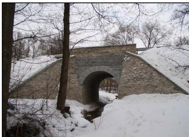
Pohled – most po sanaci
