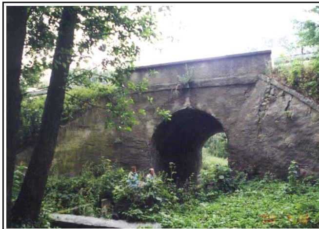
Stav objektu před sanací
