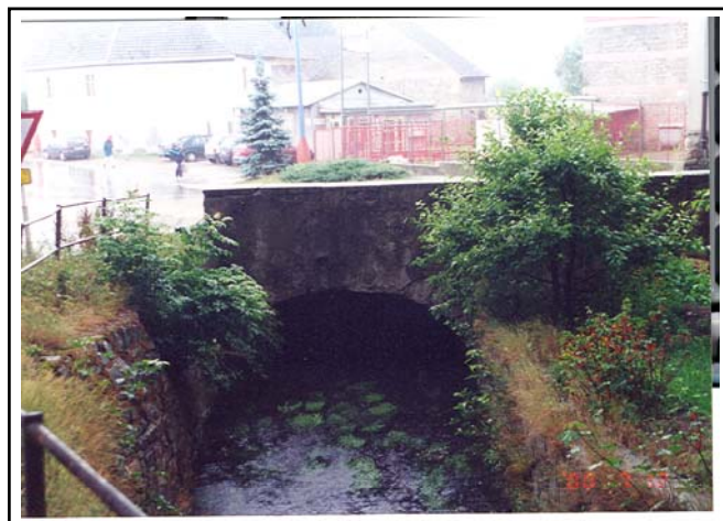
Stav mostu před opravou
