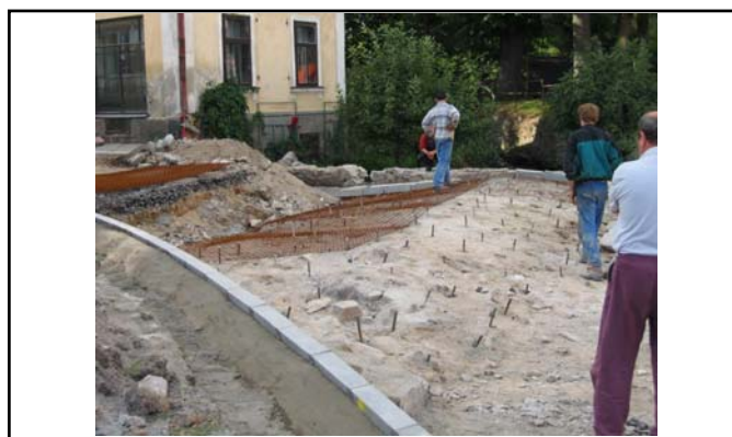
Sanační práce – armování rubové klenby
