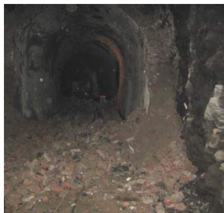
Zahájení rekonstrukce – bourání cihelné obezdívky
