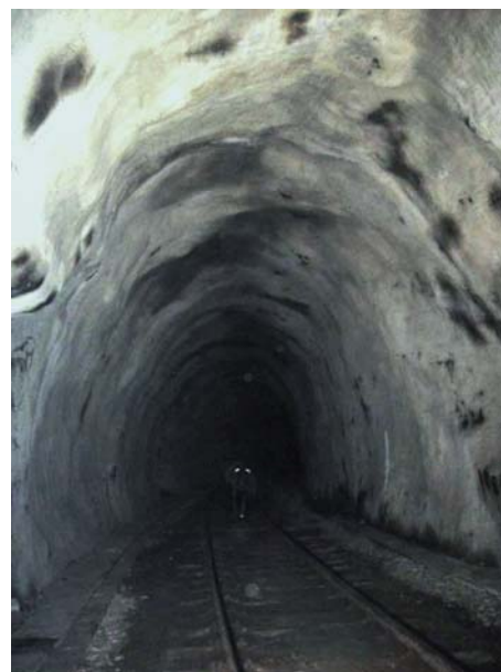
Pohled do tunelu – část s ostěním ze stříkaného betonu
