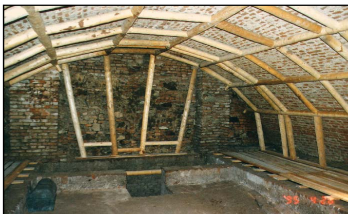
Provizorní zajištění hrobky
