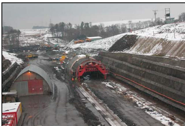
Hloubená část Brno - výstavba
