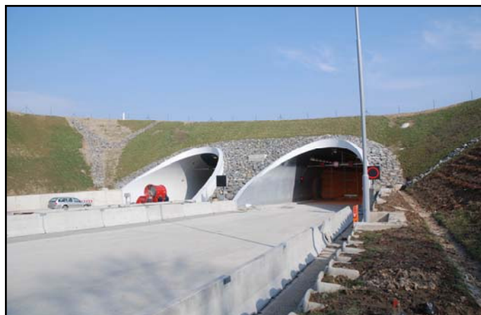
Brněnský portál dokončeného tunelu
