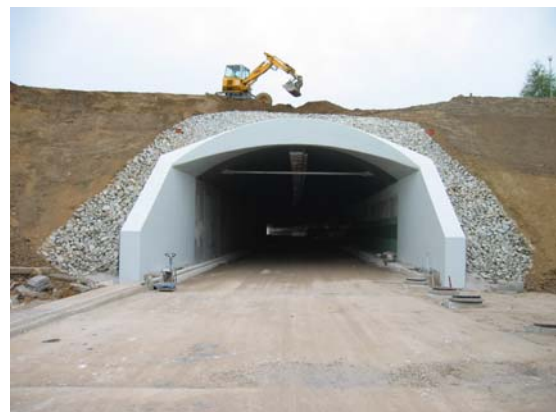
Jižní portál před dokončením
