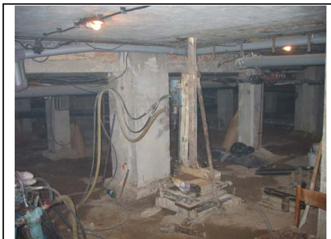
Vrtání mikropilot ve stísněných prostorách suterénu
