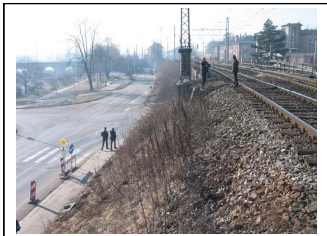
Stávající stav – pohled na původní násyp
