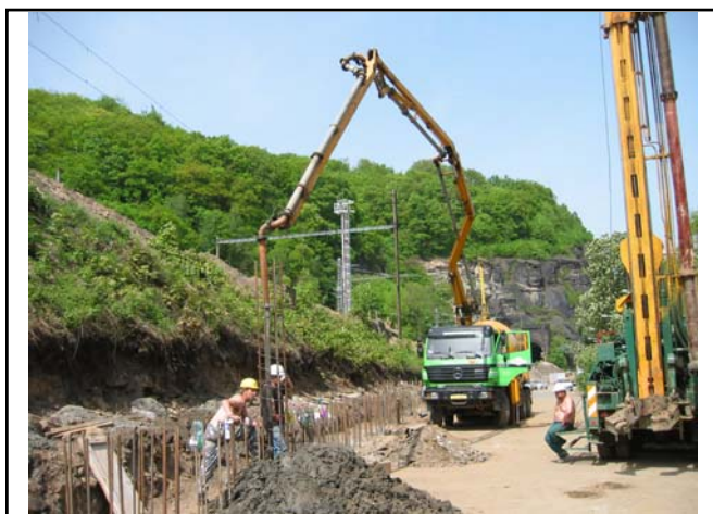
Foto pilotáže v patě dříku opěrné zdi
