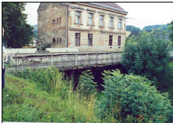
Stav mostu před rekonstrukcí
